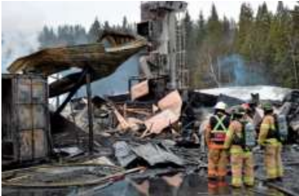
Source : Service de sécurité incendie Incendie Moulures SMDT - Arrondissement de La Baie
