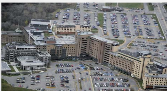
CIUSSS, 305, rue Saint-Vallier - Risques très élevés
