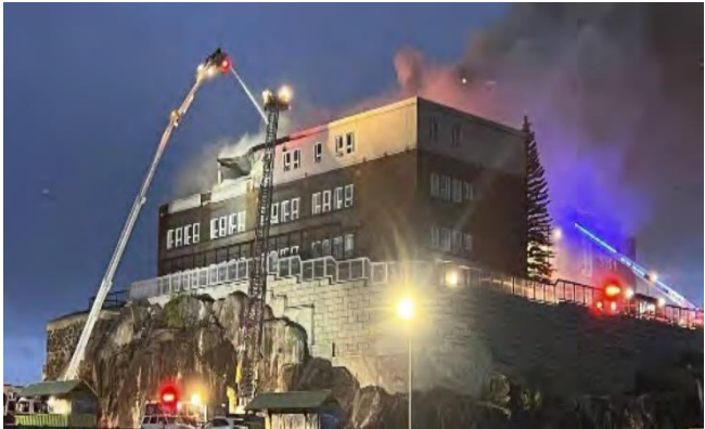
Incendie de bâtiment – OMH de Jonquière – rue Saint-Dominique
