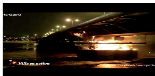
Incendie pont Dubuc, décembre 2013
